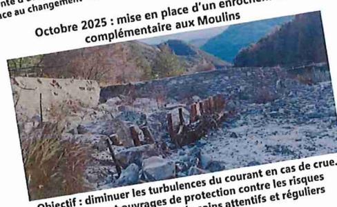
Objectif : diminuer les turbulences du courant en cas de crue.
